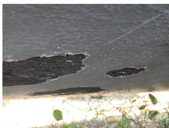
Zonas afectadas por corrosión.
