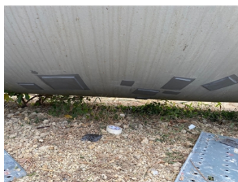
Chapas metálicas adheridas con Belzona 1161 (Super UW-Metal).
