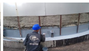
Application du Belzona 5811 pour protégé le doublant de l'environnement.
