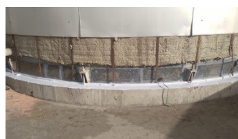
Blindage de la partie inférieure du bac.
