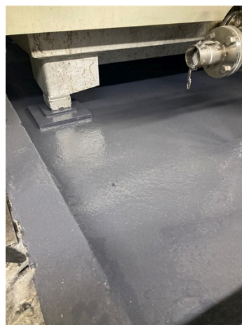
Belzona 4311 applied
