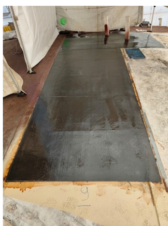
Pose de la première couche.
