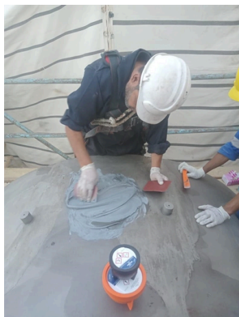
Applying Belzona 1111
