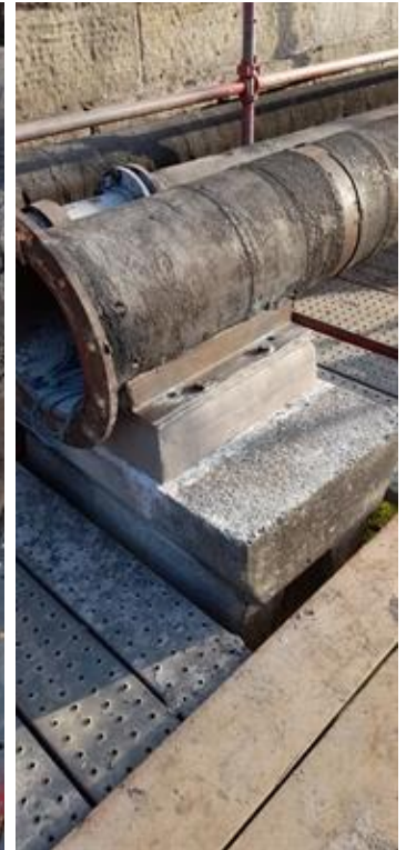
Larger support repaired using shutter & pour method
