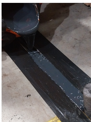
Pouring in the Belzona 2211 Hi-Build Elastomer
