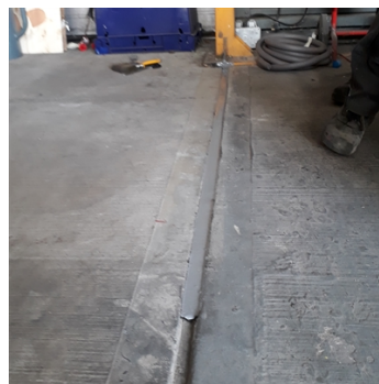
Pouring in the Belzona 4521
