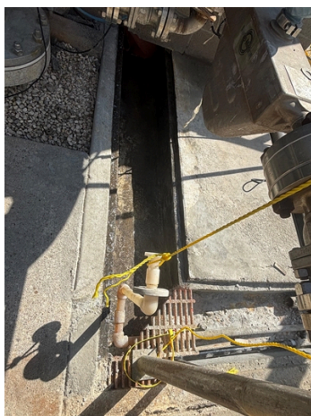
Belzona 4911 conditioner applied
