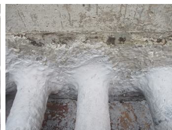
Belzona 4911 & Belzona 4111 applied
