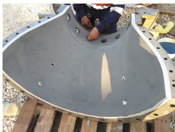
Superficie preparada y delimitando con cinta.
