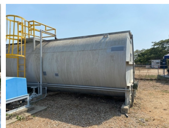
Vista general del tanque reparado
