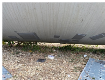
Chapas metálicas adheridas con Belzona 1161 (Super UW-Metal).
