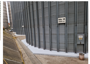
Alle Tankfundamente repariert und mit Belzona 3111 geschützt
