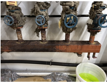
Korrodierte Verteiler
