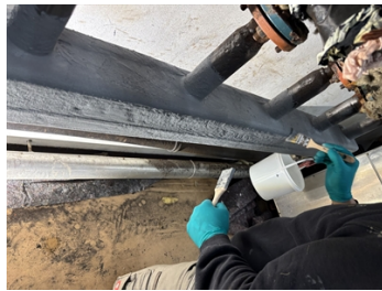
Untergrund mit Belzona Pastenprodukten repariert
