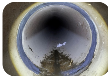
Belzona 1311 (Ceramic R-Metal) filled the flange
