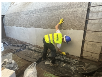
Aplicação de Belzona 4111 Magma-Quartz.
