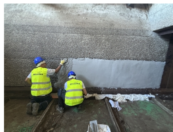
Aplicação de Belzona 4111 Magma-Quartz.
