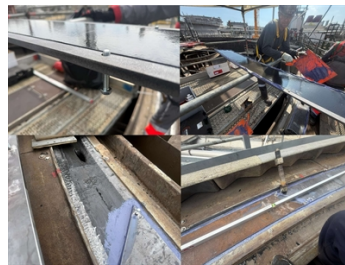
Anpassung und Verklebung der Bleche
