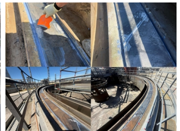
Verspachtelte Bohrungen und fertige Anwendung
