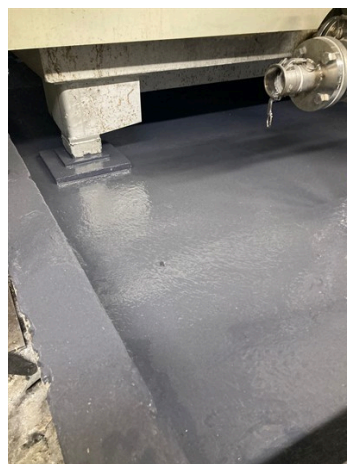
Belzona 4311 applied
