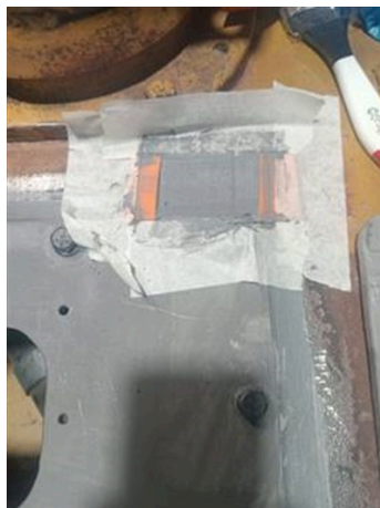
Aplicación de Belzona 1111 como soldadura en frío
