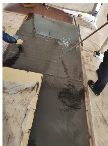
Utilisation des débulleurs après l'application d'une couche de SWII.
