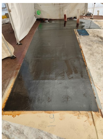
Pose de la première couche.
