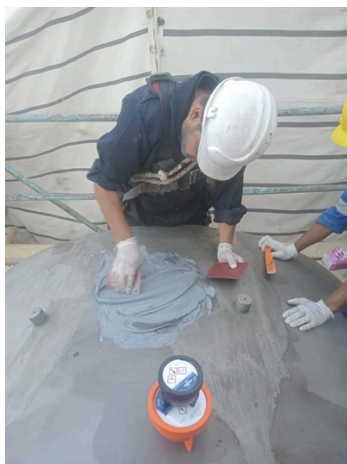
Applying Belzona 1111
