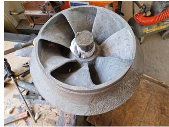
Filling damaged blades with Belzona 1311 (Ceramic R-Metal).
