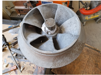
Filling damaged blades with Belzona 1311 (Ceramic R-Metal).
