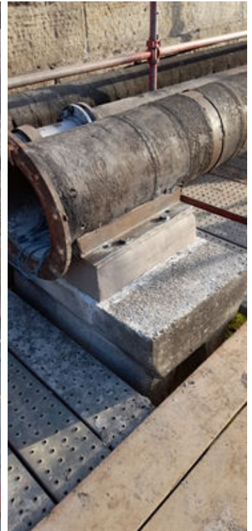
Larger support repaired using shutter & pour method
