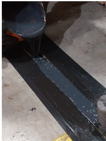
Pouring in the Belzona 2211 Hi-Build Elastomer
