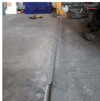
Pouring in the Belzona 4521
